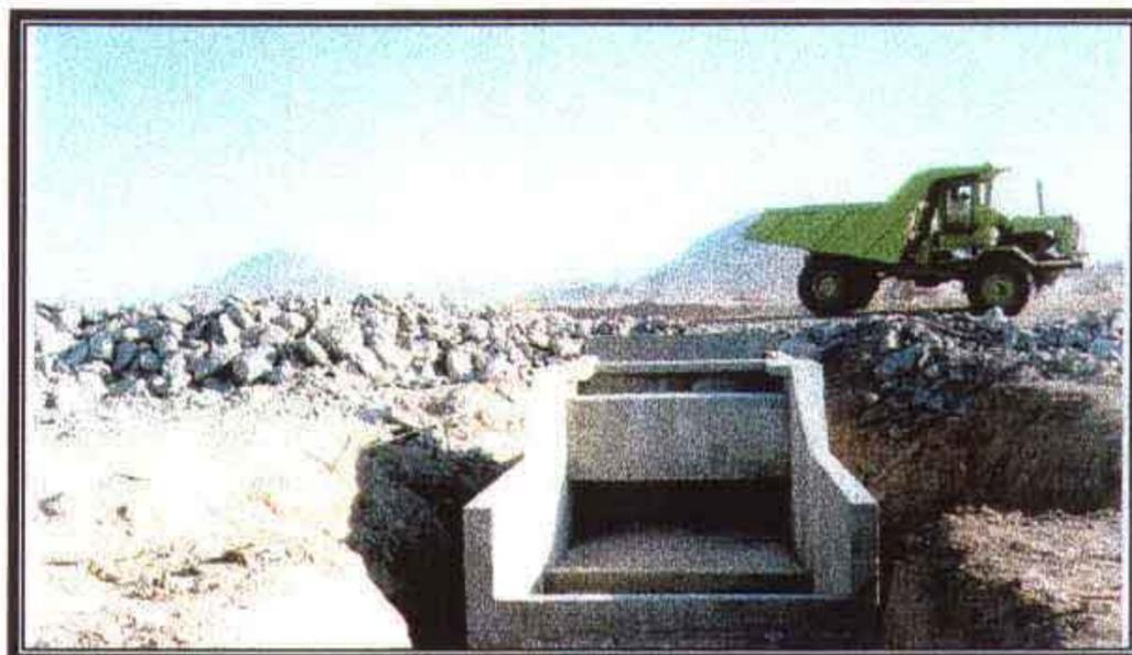
FOTO Nº 01: Tomada D'água. Caixa dissipação.
