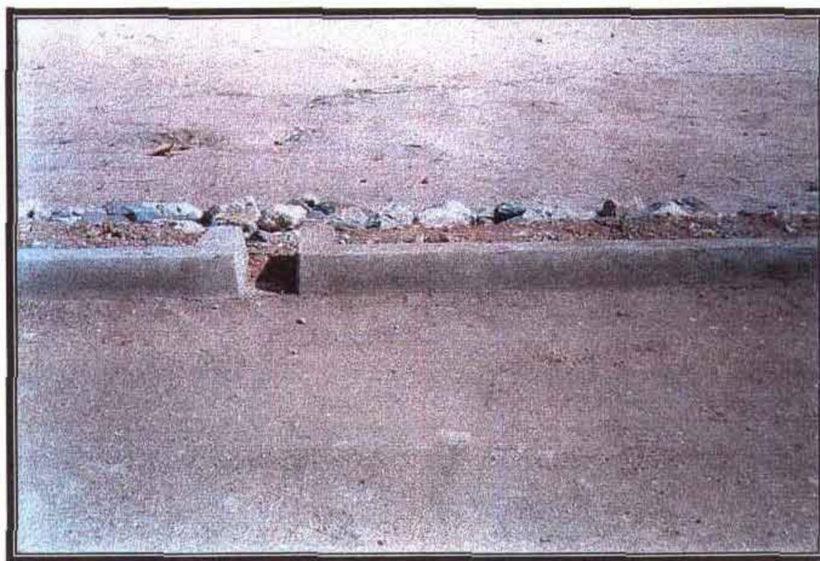
**FOTO Nº 04:** Foto mostrando a construção de uma entrada de descida d'água do meio-fio.
