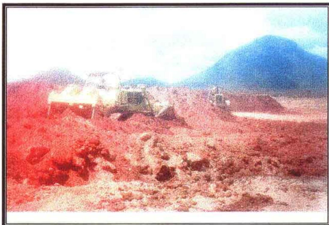
**FOTO N° 05:** Na jazida de solo argiloso J02-A. Escavação e homogeneização do material.
