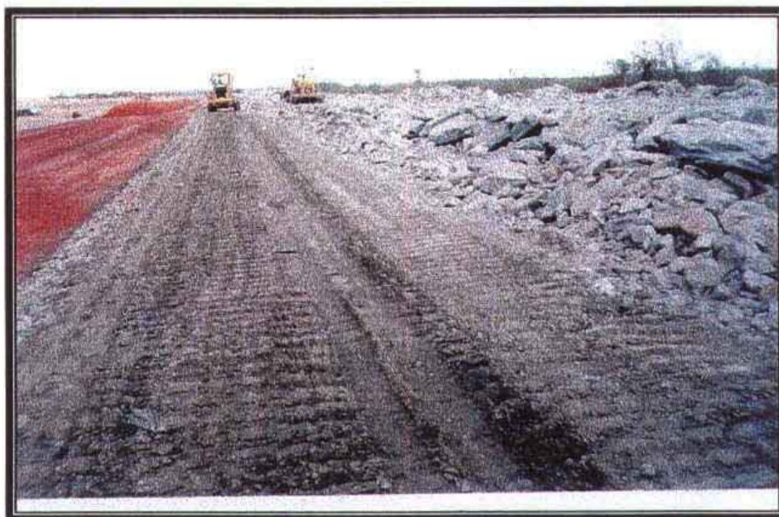
FOTO Nº 12: Material impermeável & Transição fina & enrocamento, em fase de execução.
