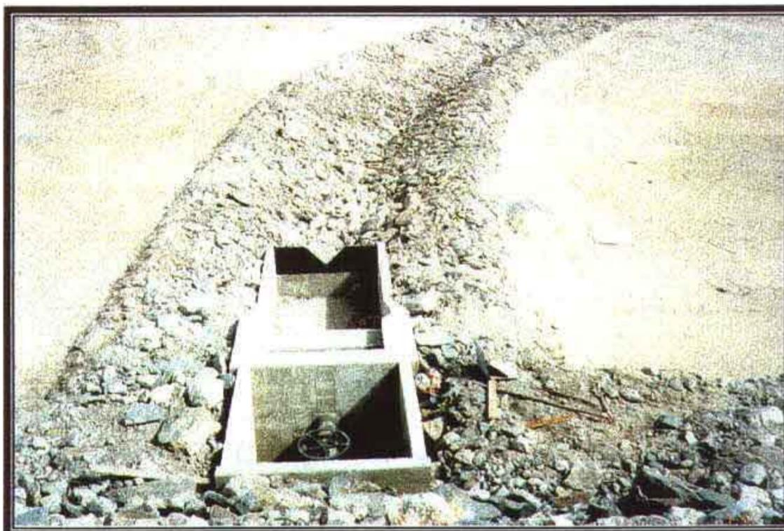
FOTO Nº 07: Caixa de dissipação da Tomada D'água, à jusante.
