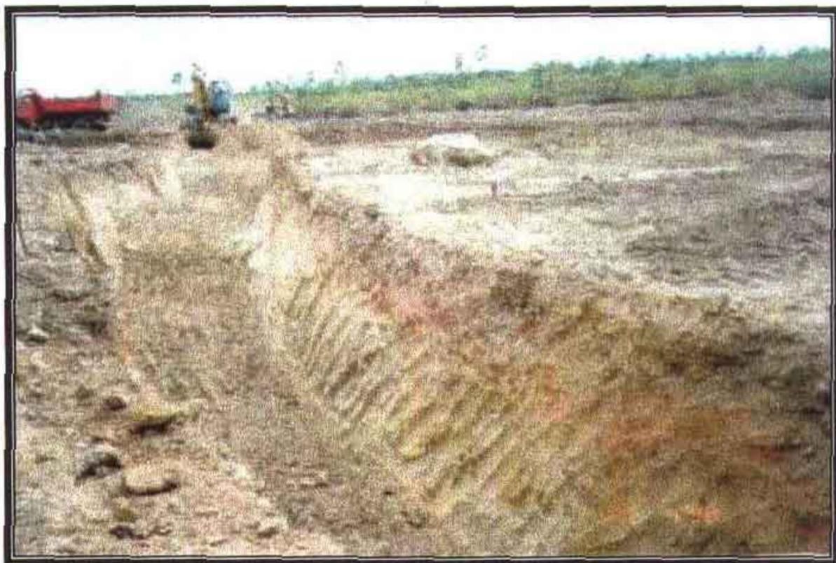
FOTO Nº 02: Tomada d'Água vista da escavação de jusante na estaca 1J.
