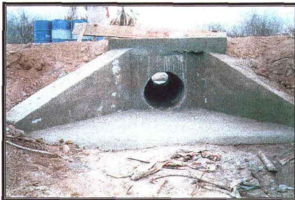
**FOTO Nº 05:** Boca de bueiro na estrada construída dentro da poligonal de contorno da bacia hidráulica.
