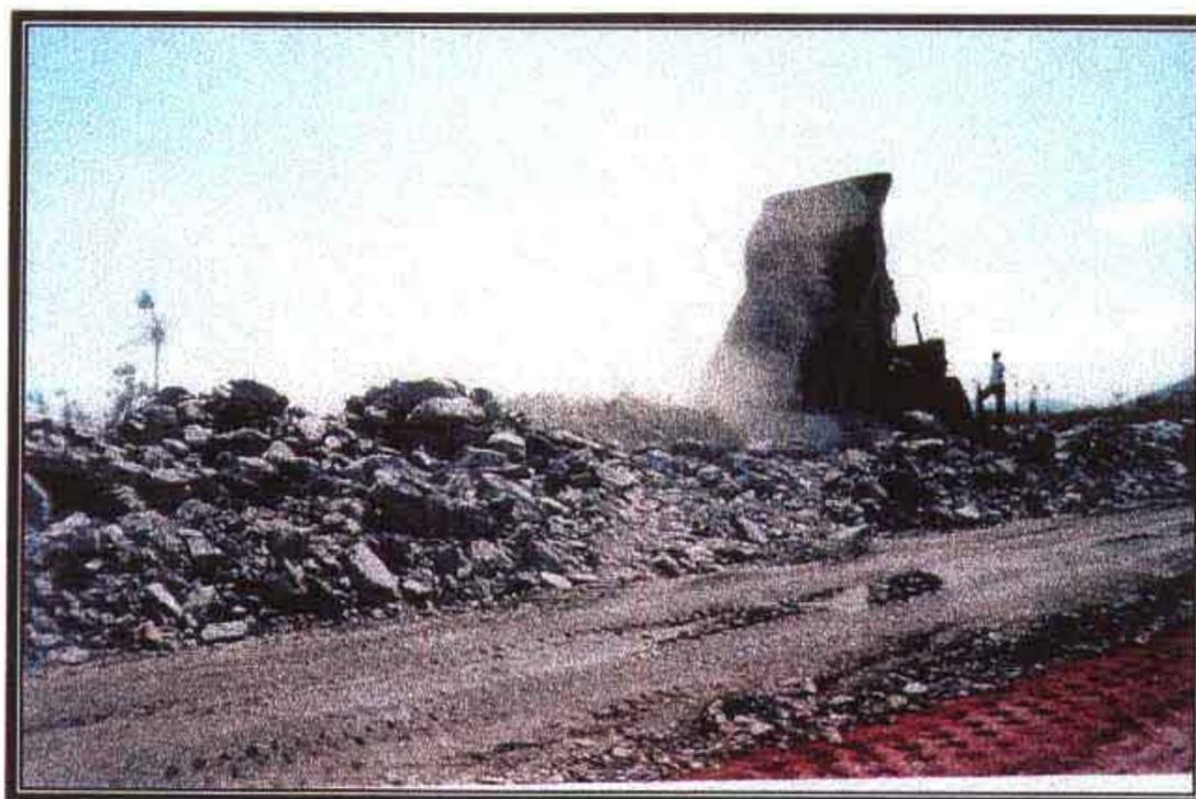
**FOTO Nº 13:** Descarga de material rochoso, para enrocamento de jusante.
