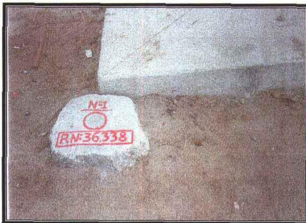
**FOTO N° 05:** Referência de nível em bloco de rocha, implantado na calçada do alpendre do posto de observação do reservatório. (P.O.R)
