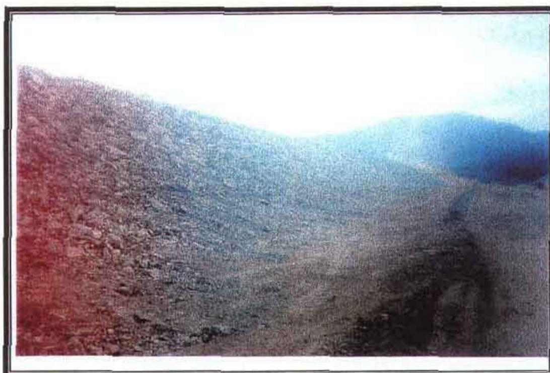
**FOTO Nº 09:** Rip-rap. Vista do talude do rip-rap, de montante, de dentro da bacia; longitudinalmente, um caminho de serviço.
