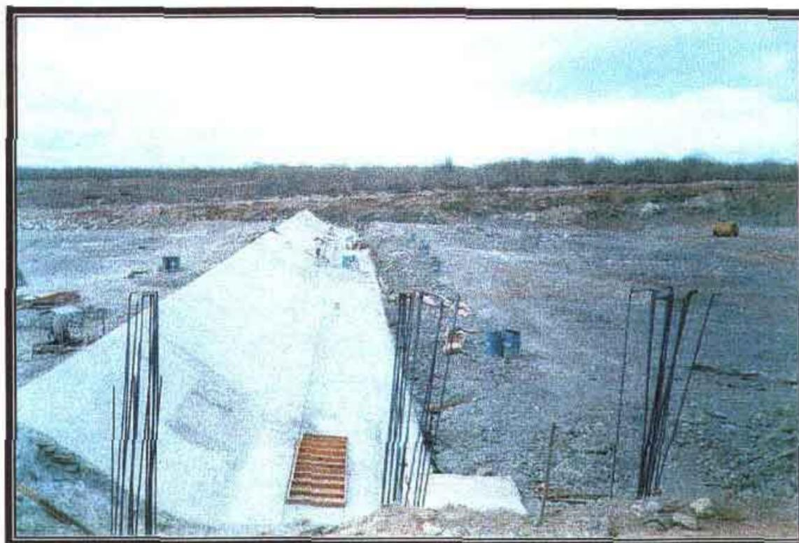
FOTO Nº 02: Fase construção do creager, vista da estaca E-1. A ferragem dos contrafortes do muro lateral.
