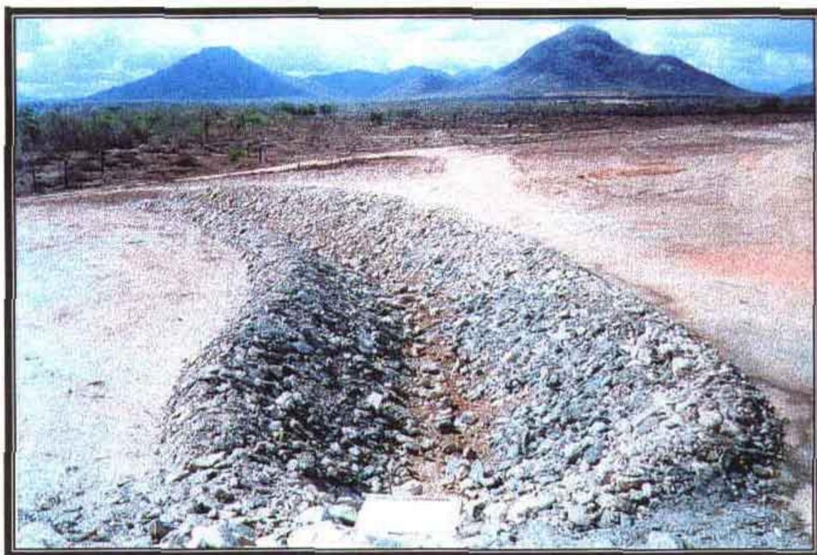
**FOTO Nº 06:** Foto mostrando o revestimento do canal da caixa de entrada da Tomada D'água, do alto da estaca 24+5,00 m, que ficará submerso, quando cheio o lago.
